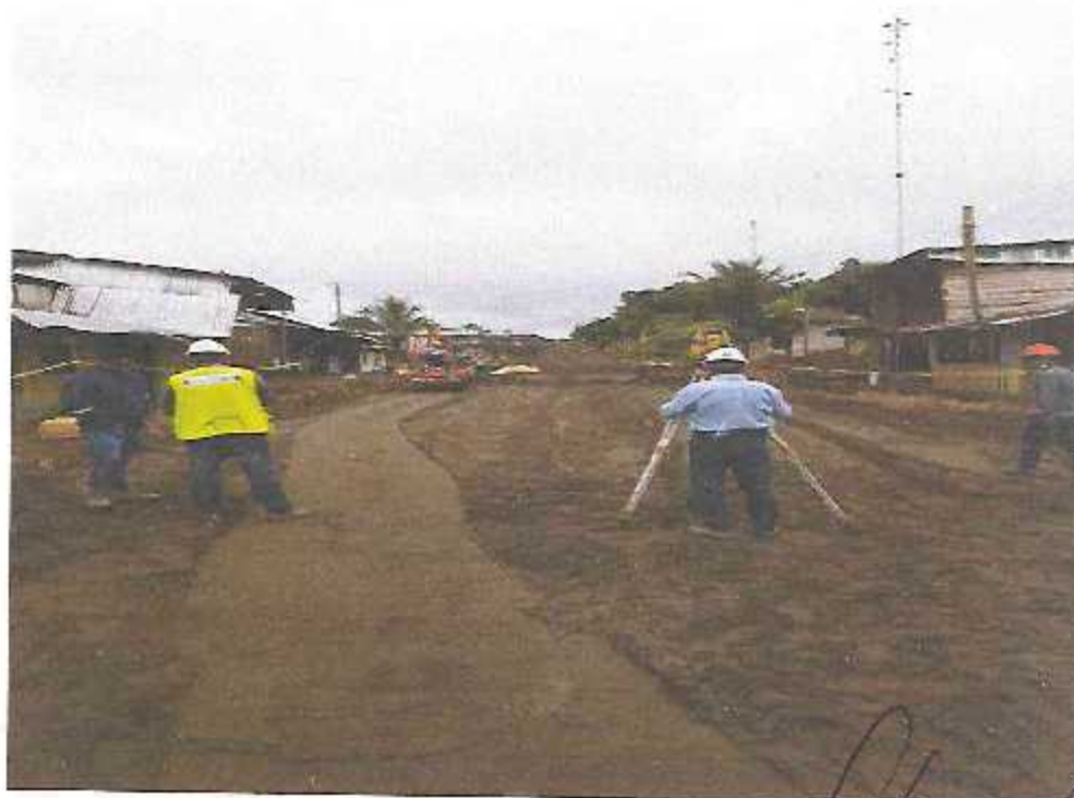
Conformando la sub rasante
