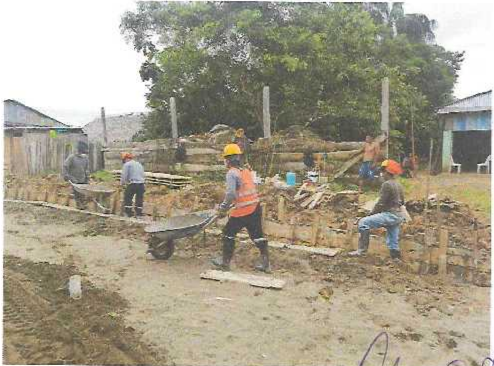
Vaceado de mortero f'c= 175 kg/cm2 en sardinel
