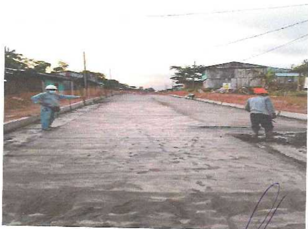
Vaceo de mortero en solados
