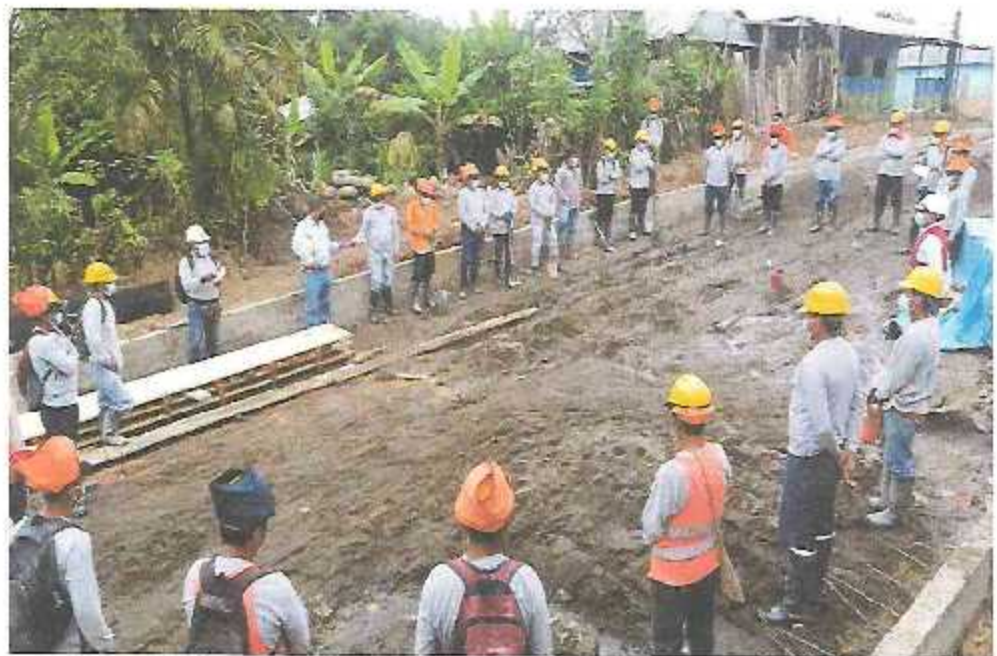
Charla de inducción y seguridad a inicio de obra
