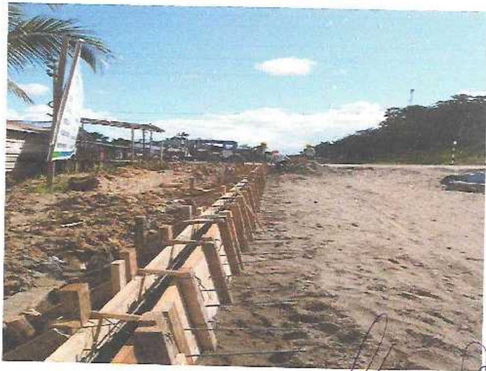
Encofrado de sardineles
