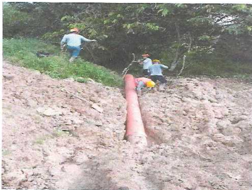
Colocación tubo alcantarillado de cruce
