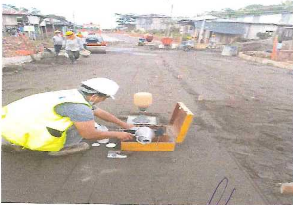
Pruebas de compactación ( densidad de campo)
