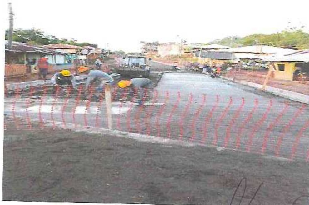
Vaceo de mortero en solado
