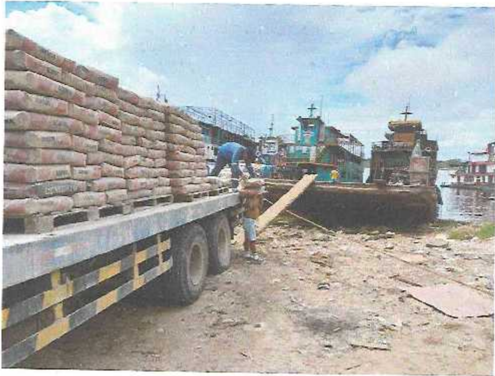
Trasporte y acopio de cemento a obra
