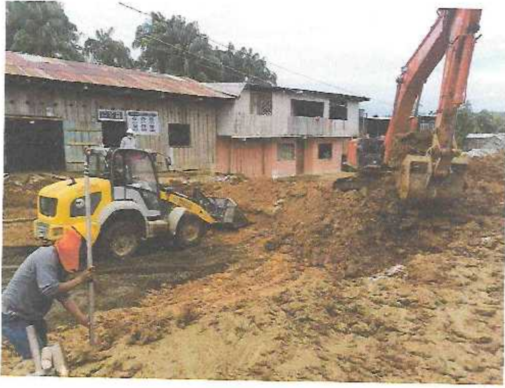
Excavación de terreno a nivel sub rasante
