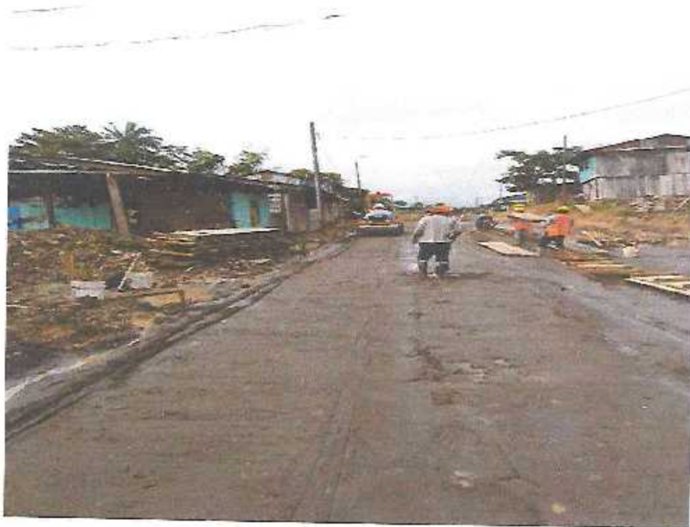
Compactación con mini rodillo
